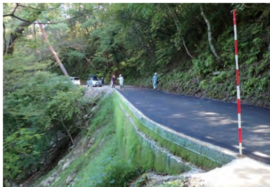
復旧後(令和6年8月)撮影
