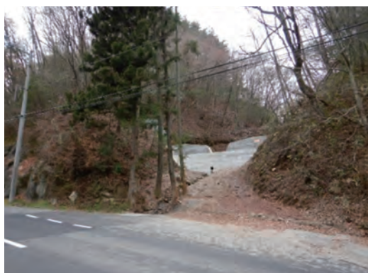
復旧後(令和6年11月)撮影
