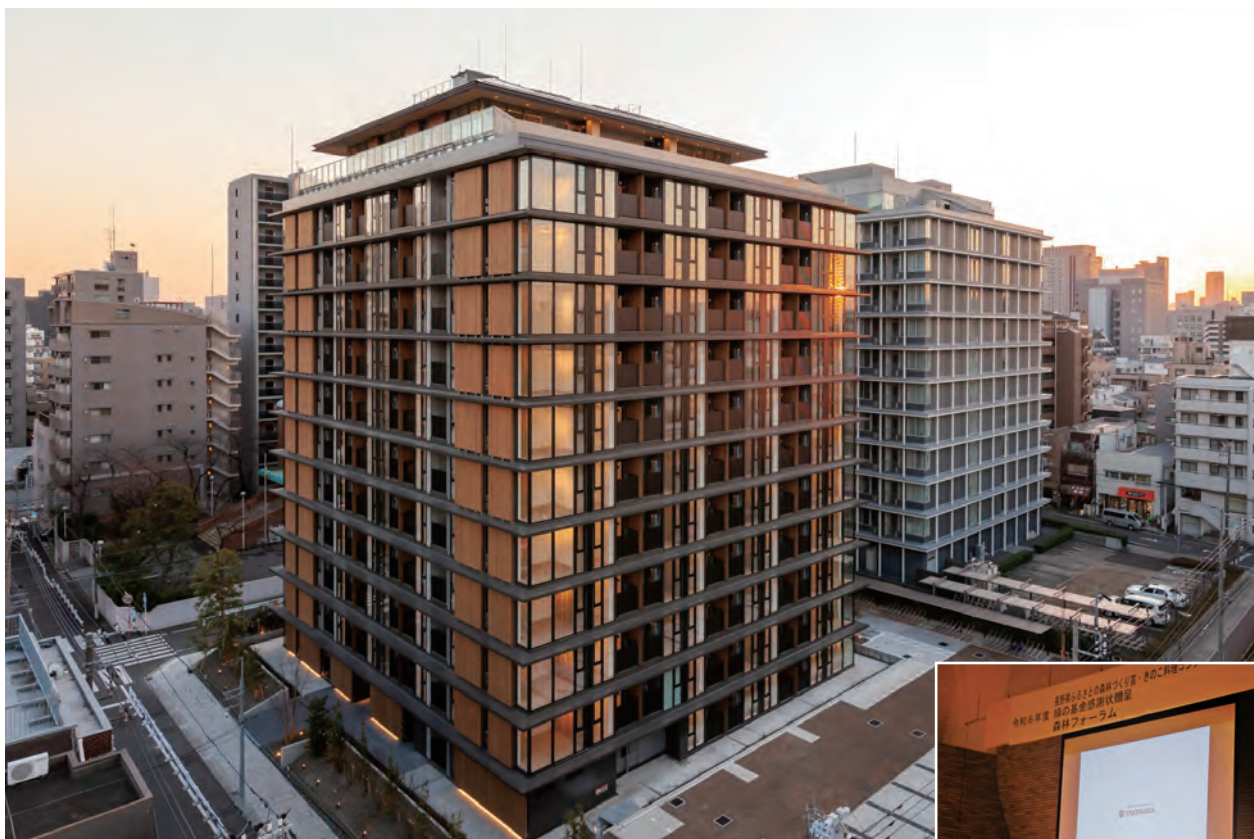
【構造部に長野県産材を用いた高層木造建築物： フラッツウッズ木場(東京都江東区)】 設計施工：株式会社竹中工務店
