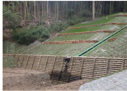
土留工に木製校倉式土留工を採用し、県産材を積極的に利用(復旧治山事業第20号工事)
