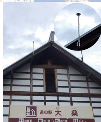
▲木曽南部森林組合に設置した基準局 拡大したものがGNSSレシーバー
