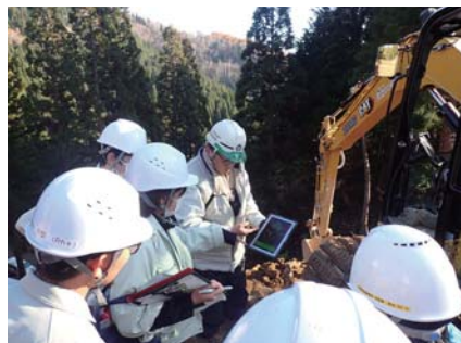
ICT施工の説明を受ける
