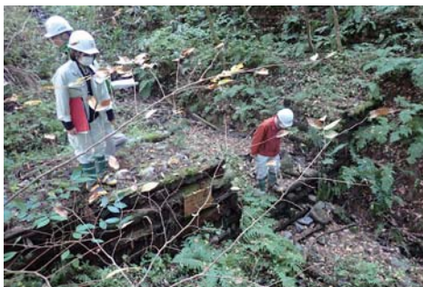
木製治山堰堤の経年劣化状況を確認
