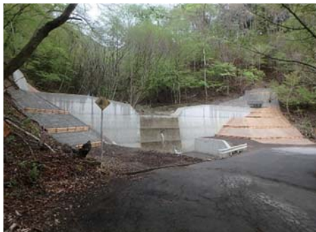
残存型枠・筋工における県産材の積極的な活用 (富士見町機能強化・老朽化対策事業第12号工事)
