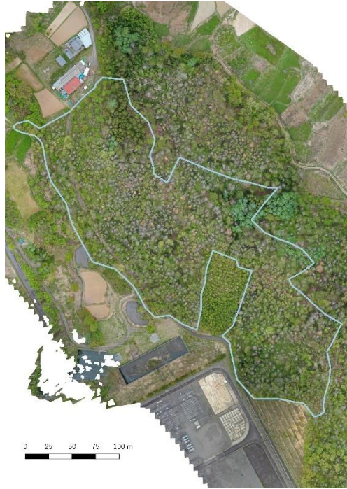
図-4 事業地オルソ画像 (A 施工区)
