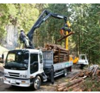
トラックへ積み込み
