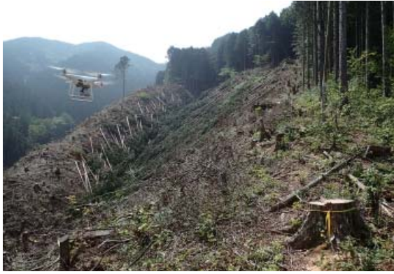
ドローンによる現地確認
