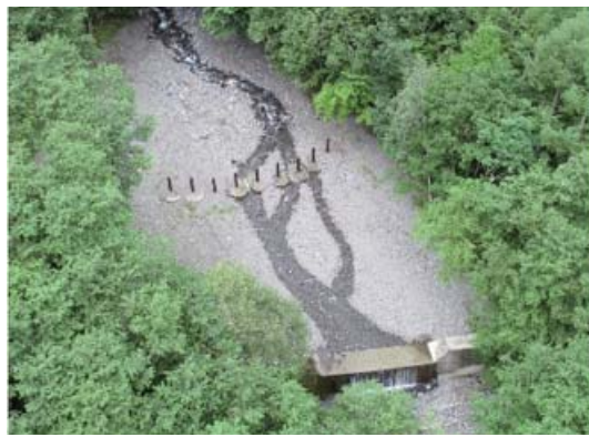
流木対策の実施(流木捕捉工)
