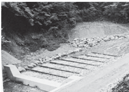
階段式木工沈床の施工状況写真 (岡谷市 横川山)
