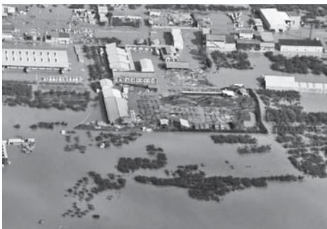
水に浸かった北信木材センター 撮影：©アジア航測(株)・朝日航洋(株)
