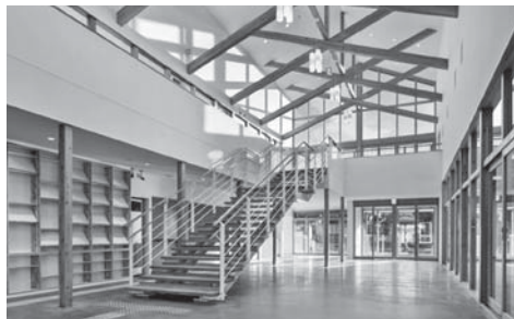
方杖が連続する支所棟吹抜け
