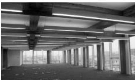
耐火集成材を使用した施工例(齋藤木材工業(株)HPより)
