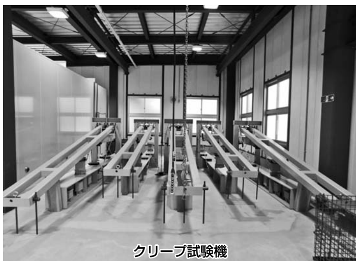
新たに建設した木材長期荷重試験棟
