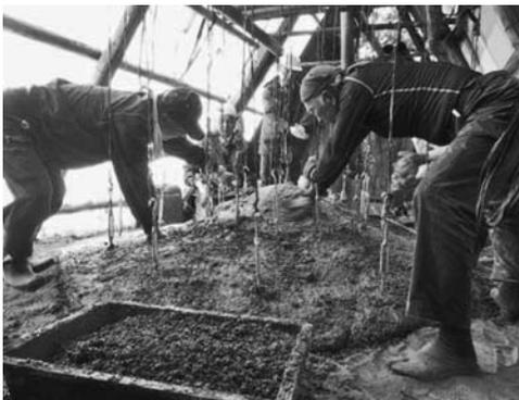
設置した鉄板の上に砕いた赤土と石灰を混ぜたものをのせている様子
