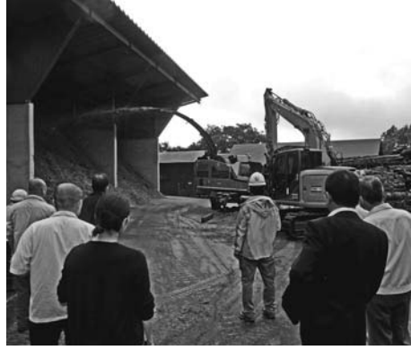
いづな お山の発電所現地視察研修の様子
