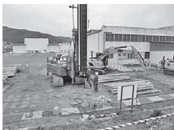
飛鳥建設の丸太打設液状化対策&カーボンストック(LP・Lic)工法
