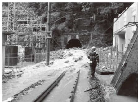
平成25年9月台風災害 泰阜村 黒見
