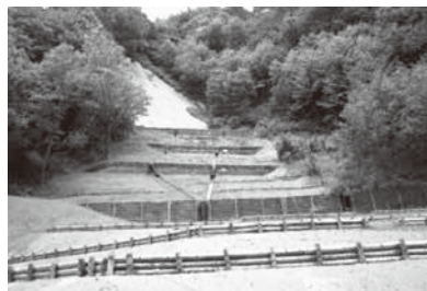
長野県上伊那地方事務所林務課 丸太筋工(上伊那郡飯島町)
