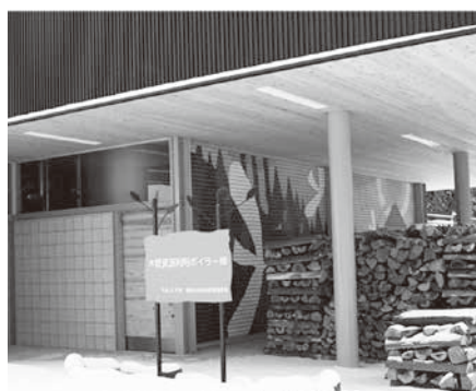
木質資源利用ボイラー棟
